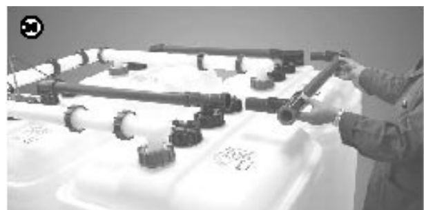
Zamontować wcześniej przygotowany kolektor odpowietrzenia.
