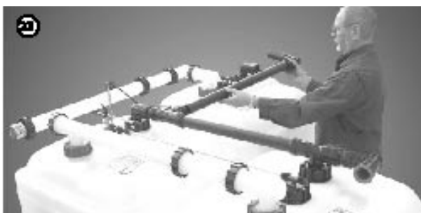
... najpierw zamontować kolano, rurę oraz trójnik z kolaniem kolektora z końcówką odpowietrzenia. Następnie zamontować rury kolektora z kolaniem.
