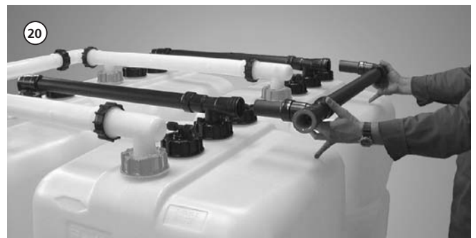
Zamontować wcześniej przygotowany kolektor odpowietrzenia;
