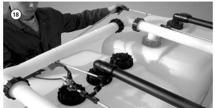
Zamontować wcześniej przygotowany kolektor poboru paliwa;
